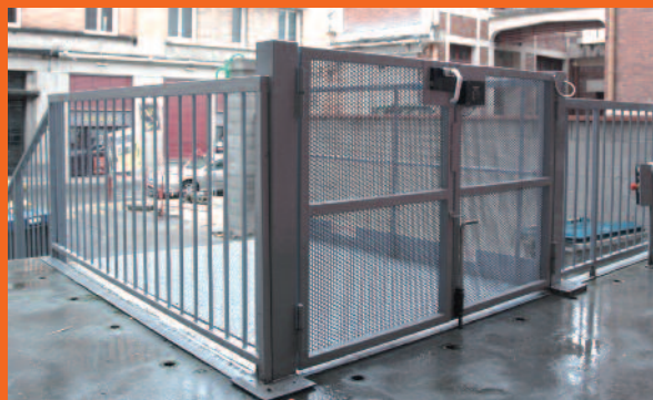
Portillon à serrure électromagnétique
